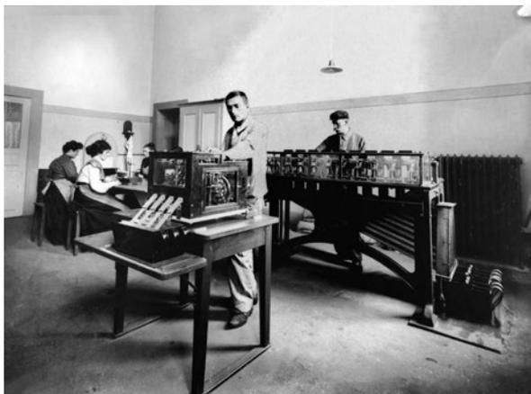
**Abb. 7: Eidgenössische Münzstätte Bern, Raum mit Wäge-/Sortiermaschine im Vordergrund, dahinter Justiermaschine<sup>9</sup>, links im Hintergrund drei Frauen, welche mittels Nachwägen die vorher übergewichtigen und nun justierten Rondellen kontrollierten.**
