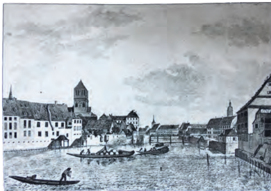
Fig. 6: Les bâtiments de la Monnaie situés à gauche sur la photo, l'église et le pont St Thomas. Gravure de la fin du 18e siècle
